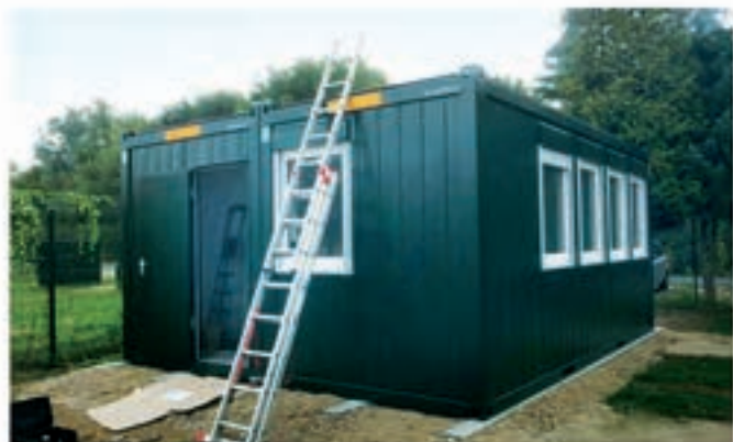
Ein paar Stunden später ist die neue Katzenstation dann fertig installiert. Wir staunten nicht schlecht. Ein kleines Meisterwerk!
